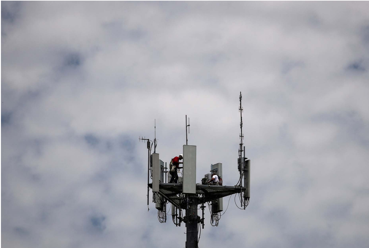
労働者は、2020年5月6日、テキサス州シーブルックにあるT-Mobile USInc. タワーに5G通信機器を設置します。
